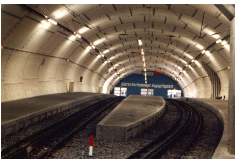
Bild 1: Zugspitzbahnhof (Spannweite 14,22 m)
