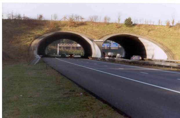
Bild 4: Grünbrücke Nationalpark Woeste Hoeve (NL) im Endzustand
