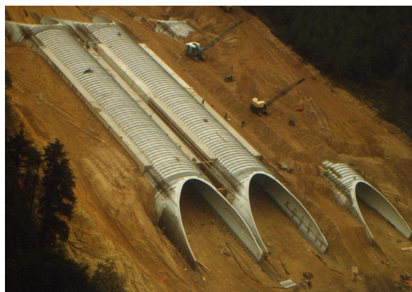
Bild 3: Grünbrücke Nationalpark WoesteHoeve (NL) im Bauzustand
