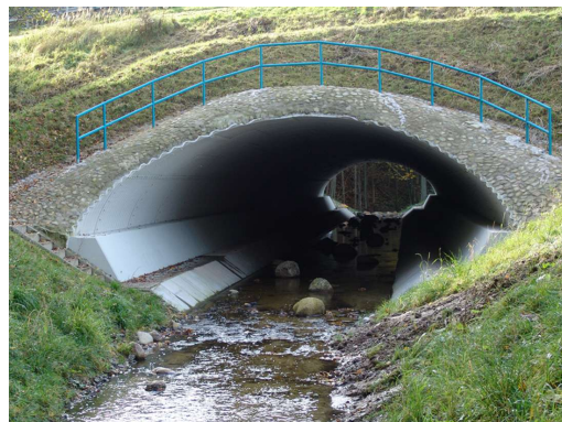
Bild 4: Fertiggestelltes Wellstahlbauwerk
